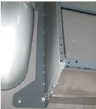
Abbildung 5.3.4.: Verschraubung Bodenhalter mit Leergehäuse
